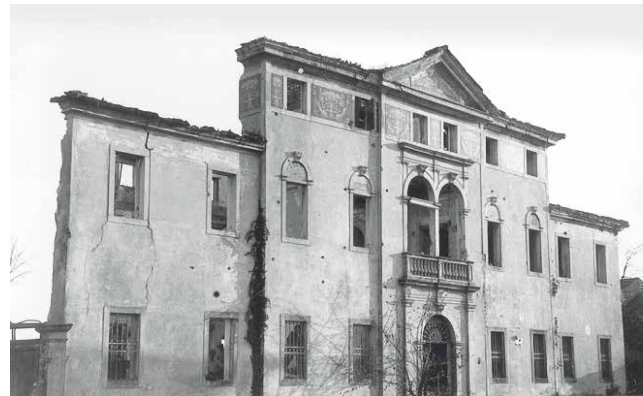
152. Villa Benedetti in Godega di Sant'Urbano durante i lavori di demolizione del 1950 circa. Treviso, Fondo Giuseppe Mazzotti, Foto Archivio Storico Trevigiano della Provincia di Treviso.
