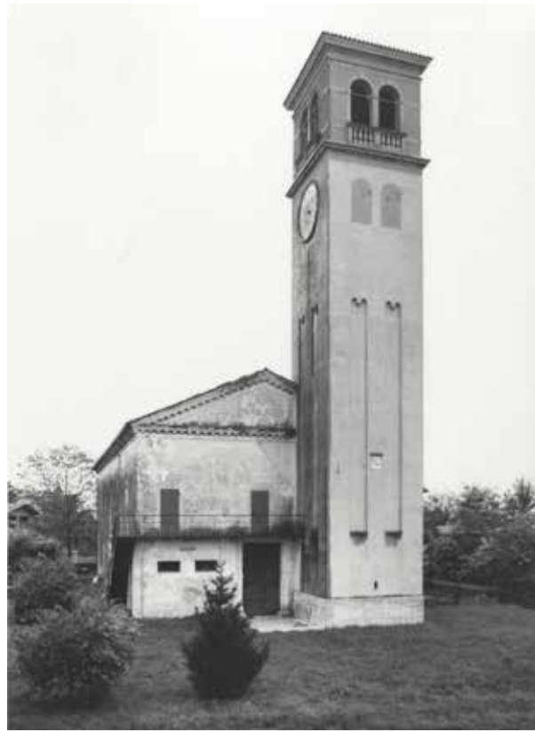
149. Chiesa antica di San Martino di Bibano, esterno.
