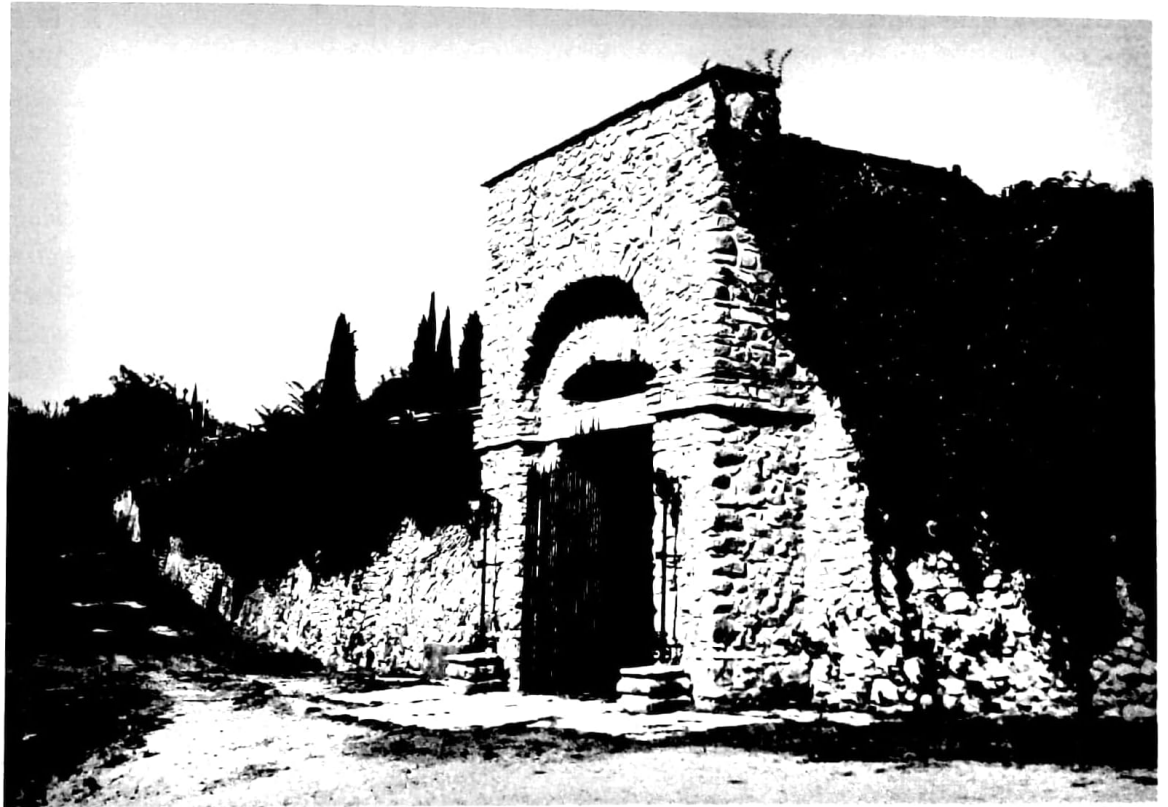
Villa Della Torre a Fumane, Grotta superiore o Bucintoro.
