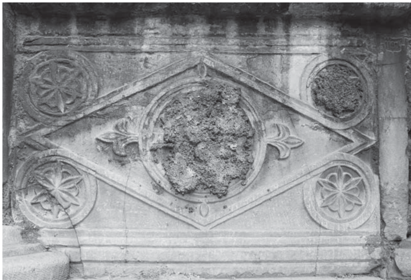
Fig. 4a - Vefa Kilise Camii, esterno, lato sud della facciata dell'esonartece, lastra centrale.
