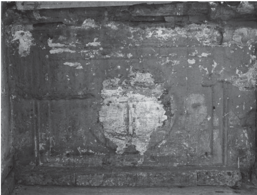
Fig. 5b - Vefa Kilise Camii, interno, lato sud della facciata dell'esonartece, lastra meridionale coperta fino al 2015.
