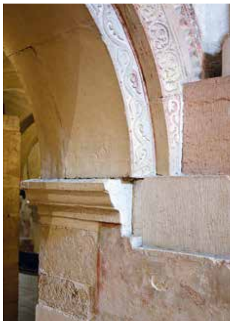
Fig. 33. Settore centrale dei varchi di accesso, con il punto di contatto fra la quinta arcata e il pilone sud della navata.
