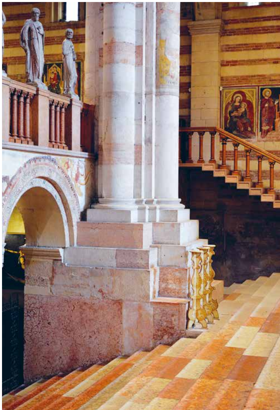
Fig. 19. Fronte della cripta, pilastro polistilo della serie sud della navata principale.
