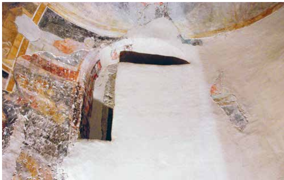
Fig. 3. Catino minore nord di epoca carolingia visibile dal presbiterio, con evidenziata la grande finestra mediana, occlusa nelle fasi successive di trasformazione della chiesa.
