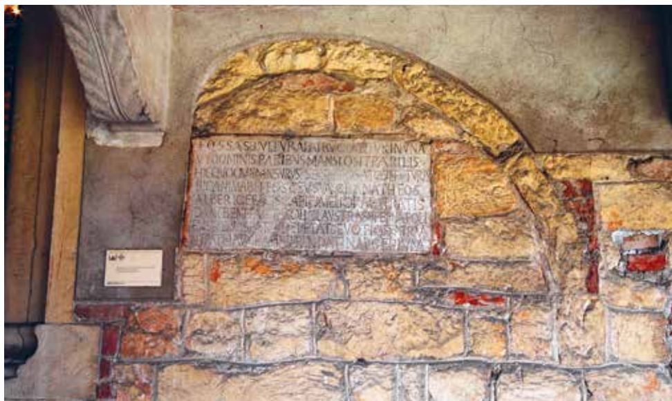
Fig. 4. Muro perimetrale nord, visto dall'esterno, con la tomba dei monaci e la lapide che ricorda l'abate Alberico.
