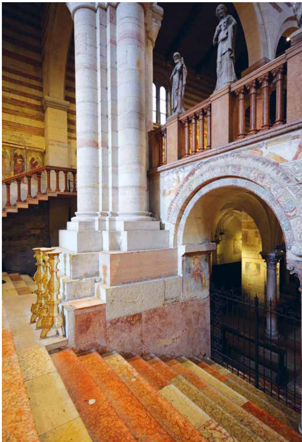
Fig. 18. Fronte della cripta, pilastro polistilo della serie nord della navata principale.
