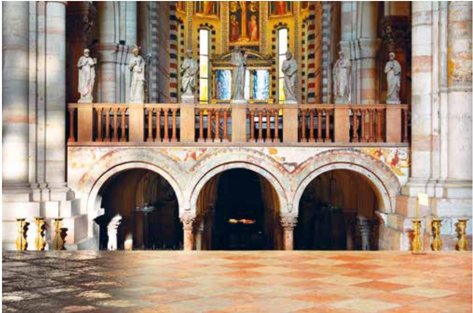
Fig. 1. Interno della basilica zenoniana con evidenziato il rapporto fra il pavimento della navata principale e il piano sopraelevato del presbiterio, sotto al quale si aprono i tre arconi mediani di accesso alla cripta.
