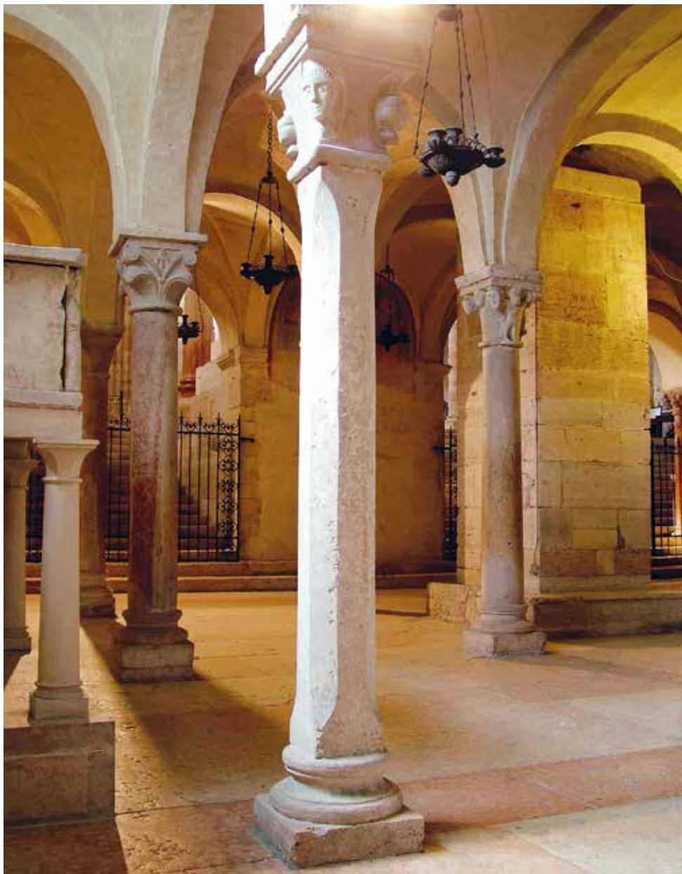
Fig. 15. Cripta, pilone sud ovest in rapporto alle circostanti strutture voltate.
