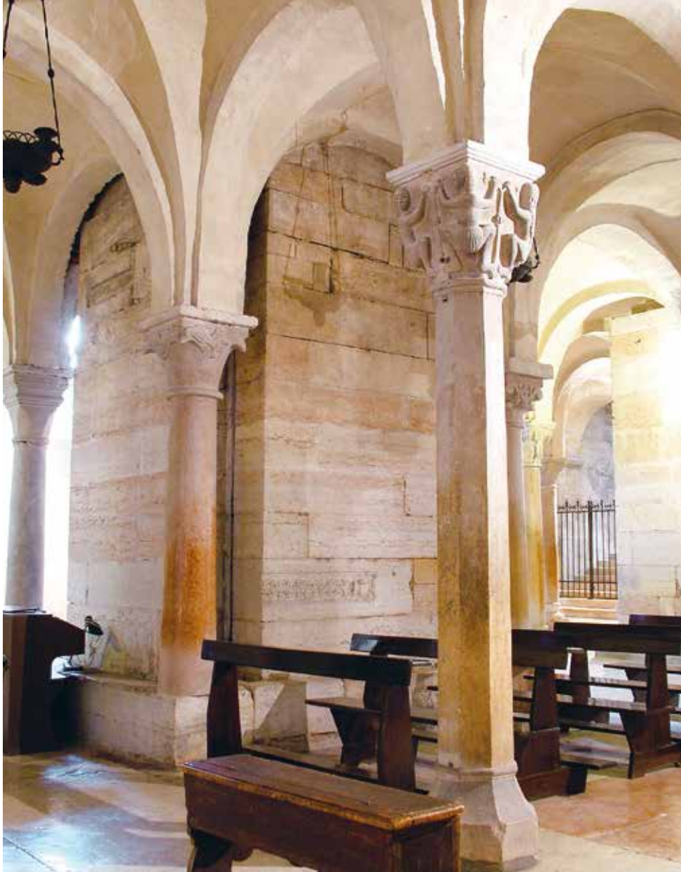
Fig. 14. Cripta, pilone sud est a sezione cruciforme.
