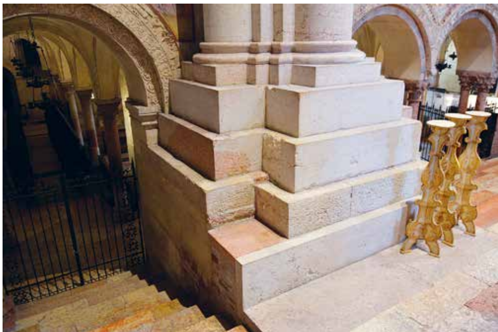
Fig. 31. Settore nord dei varchi di accesso, con il punto di contatto fra la seconda arcata e il pilone nord della navata.
