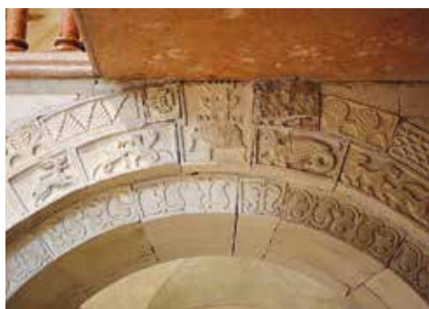
Fig. 42. Settore sud dei varchi di accesso, parte sommitale della settima arcata.
