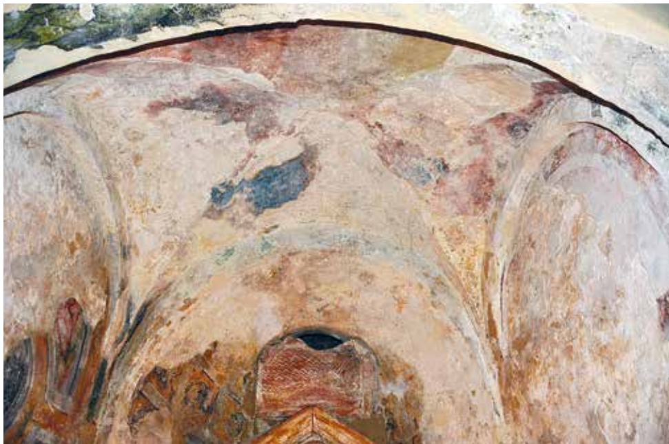
Fig. 9. Volta a crociera dell'abside minore sud, vista dall'interno della cripta.
