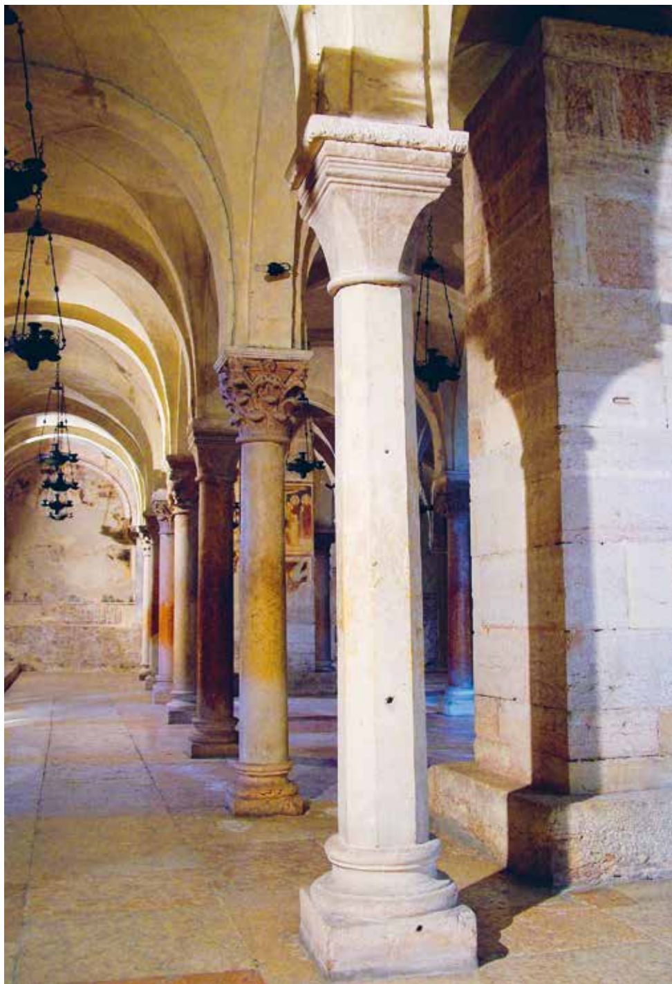
Fig. 29. Cripta, prima navata trasversale a partire dall'entrata, volte e sostegni duecenteschi.
