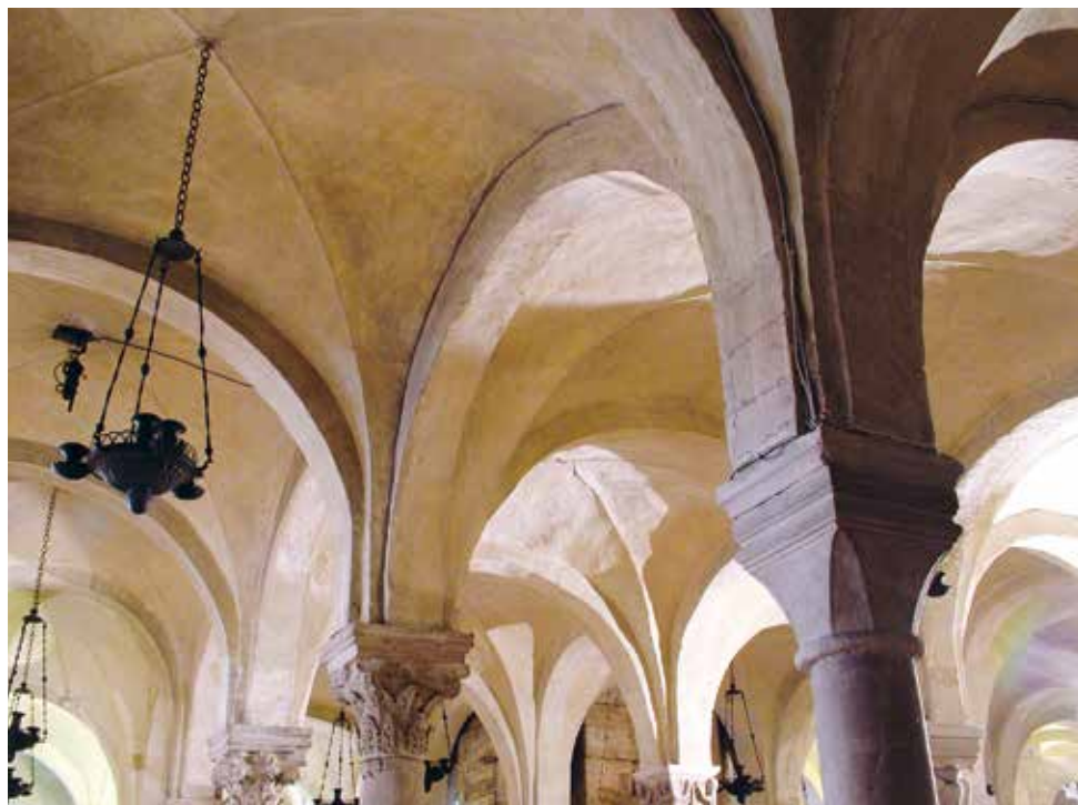
Fig. 28. Cripta, zona orientale, sistema delle volte a crociera.
