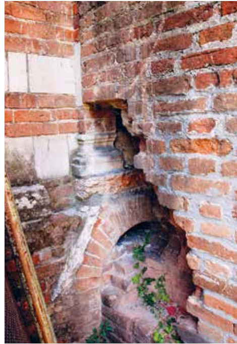
Fig. 8. Finestra della cripta della seconda fase romanica, tamponata all'interno dal piedritto nicoliano e all'esterno dal muro del coro tardogotico.
