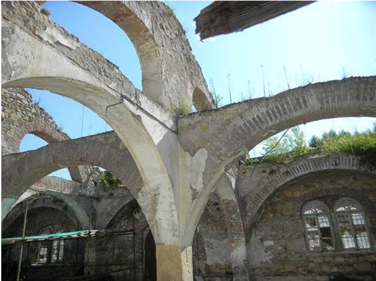
Le condizioni attuali dell'Arsenale
