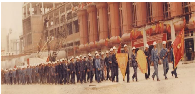
30. Sfilata di operai del cantiere raffineria Midia Navodari, 1983, fonte: MNIR (17.08.2014).
