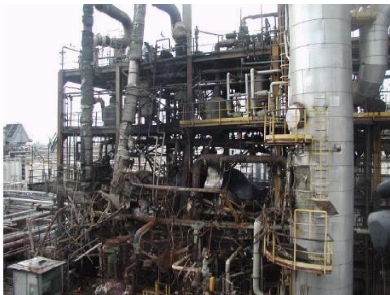
Fig. 33.: Le lamiere contorte del TDI5 il giorno dopo l'esplosione. Fonte: ARPAV
