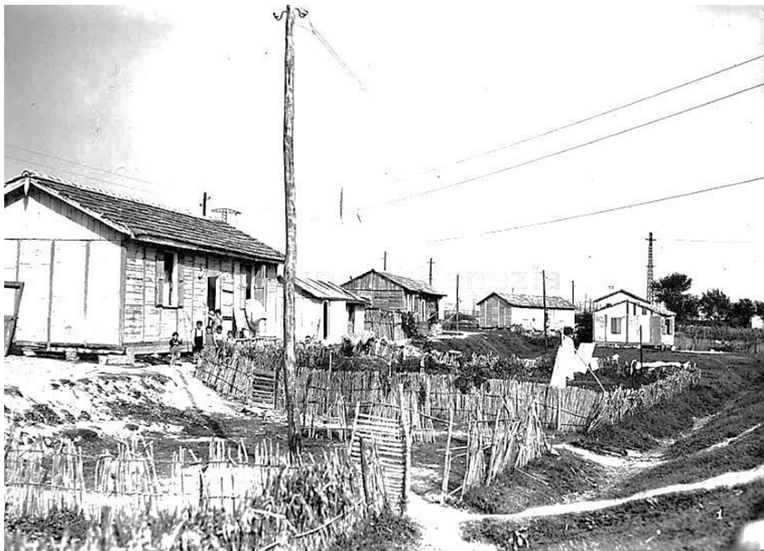
Fig 22: in realtà molte delle "casette" erano delle vere e proprie baracche. Fonte: Album di Venezia, Fondo: Comune di Venezia
