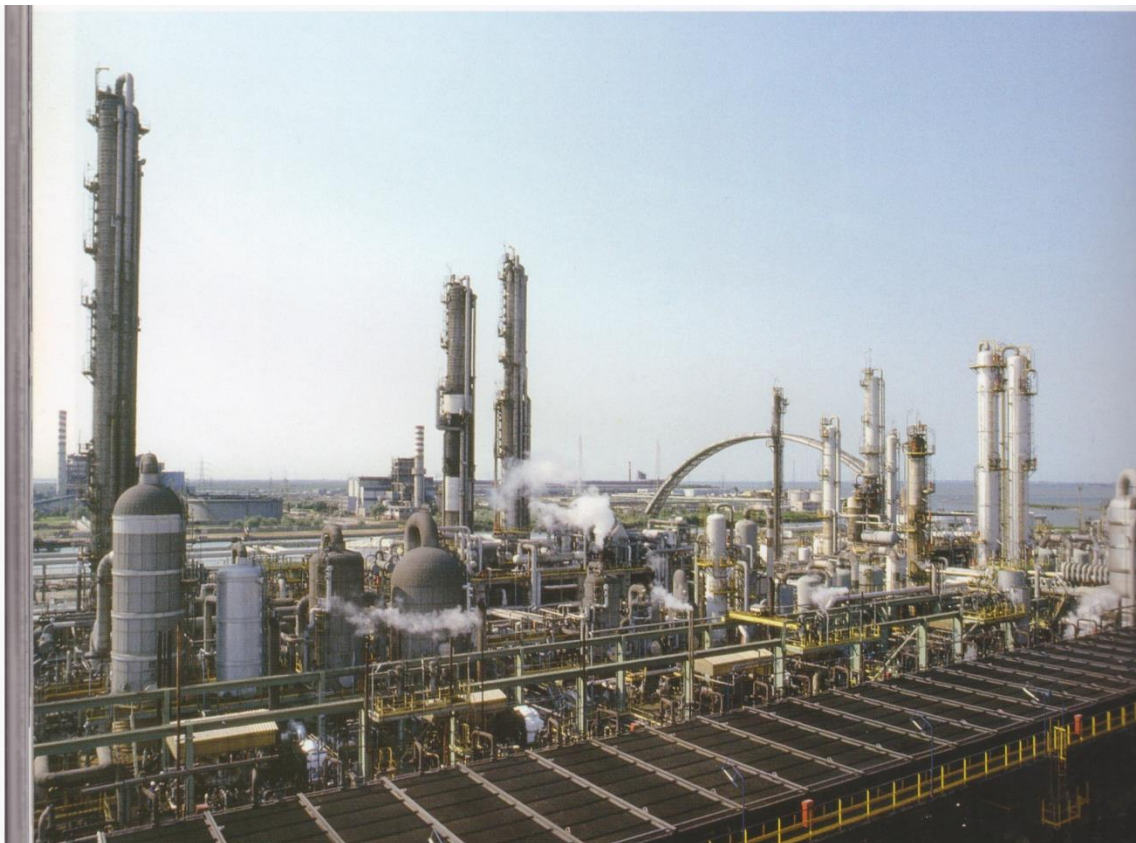
Figura 10: 1992 l'impianto di craking dell'etilene. Foto: Daniele Resini, in: Barizza e Resini, (2004).
