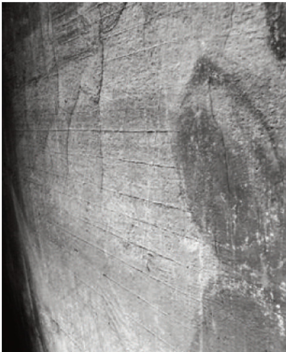
Fig. 4 - La parte centrale della composizione: si notino le incisioni sull'intonaco per delineare la prospettiva.
