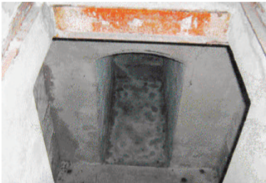
L'ingresso attuale alla cripta, al di sotto del tempietto dell'abside (Foto Paolo Bertelli).
