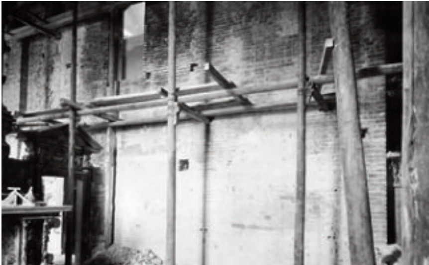
La parete destra dell'abside dopo la rimozione degli intonaci, vista generale (ASDMn, Fondo Menna, Cassa 3, b. 4).
