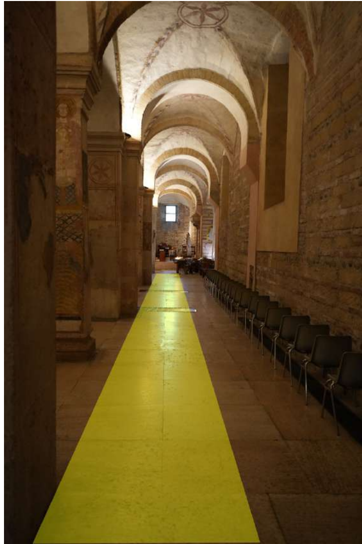
Fig. 10. Verona, San Fermo maggiore; navata minore meridionale con in giallo il rapporto fra i sostegni romanici e la posizione del muro romano evidenziata in giallo (foto ed elaborazione dell'A.).
