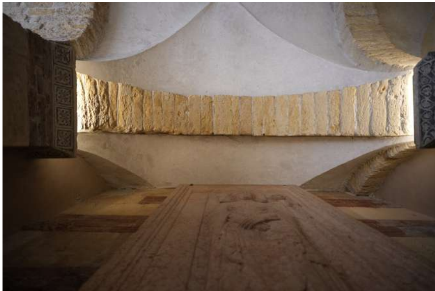
Fig. 16. Verona, l'atrio canonico; campatina sud con la volta mozzata . In basso è il muro della cattedrale romana, con appoggiata la lapide del vescovo Bonincontro (foto dell'A.).
