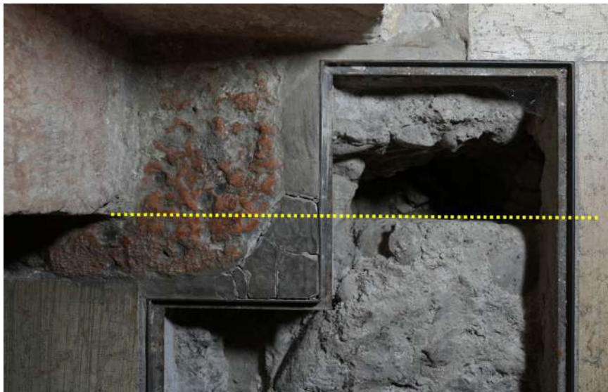
Fig. 5. Verona San Fermo maggiore; allineamento delle fondazioni del pilastro medievale con il muro dell'edificio romano (prima trincea) . In alto a sinistra si nota una porzione del piedritto cruciforme, di cui si vede il getto di fondazione nella parte superiore della trincea; in basso, oltre la linea che rimarca l'allineamento, si nota il setto dell'edificio romano (foto dell'A.).
