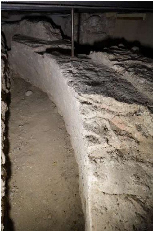
Fig. 8. Verona, San Fermo maggiore; il muro anteriore della conca altomedievale (quarta e quinta trincea) con la faccia interna e quello soprastante lisciate (foto dell'A.).
