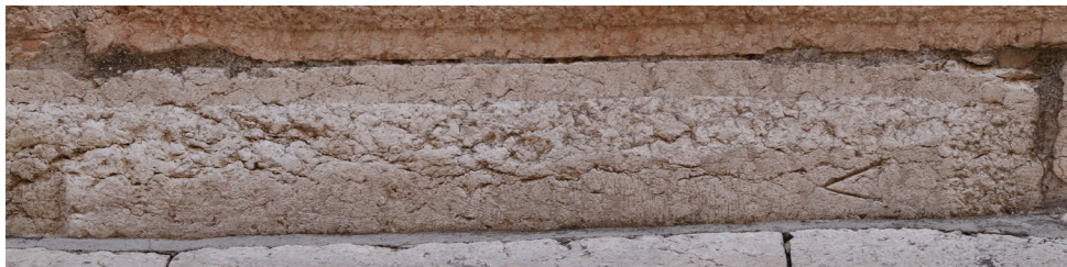
9-10. Verona, via Pietà Vecchia. Blocco e frammento reimpiegati nella parete laterale destra della facciata di Santa Maria Assunta.
