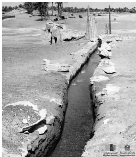
Canale di irrigazione Falaj, 1954, National Archives Abu Dhabi.
