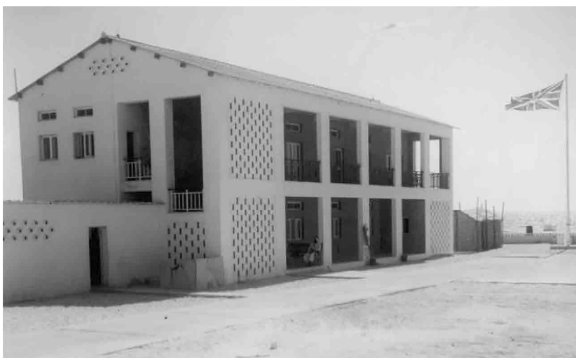
Sede del British Political Agency, costruzione moderna ubicata vicino alla costa, 1958, National archives Abu Dhabi.
