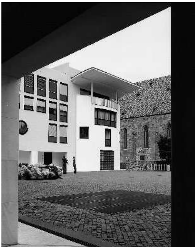
4. Centro pastorale a Bolzano. La piazza e il fronte ovest dell'edificio
