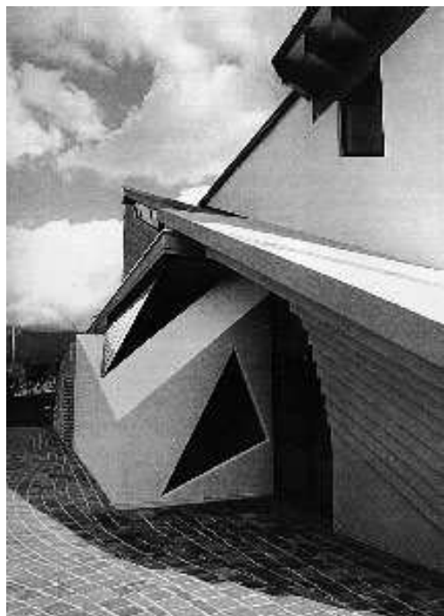
20. Particolare della facciata ovest
